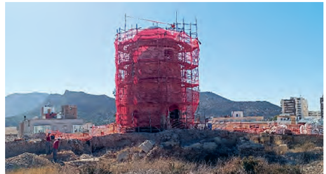
Figura 9: Molino Ermita San Cristóbal en fase de restauración (2024). Fuente: El autor.
