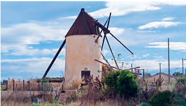
Figura 17: Molino de La Cerca (Diputación de Santa Ana) en 2024 con el botalón decadente. Fuente: El autor.
